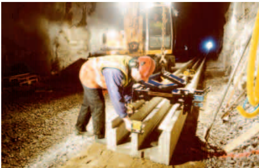
Arbete med kabelränna i Hjältatunneln.
