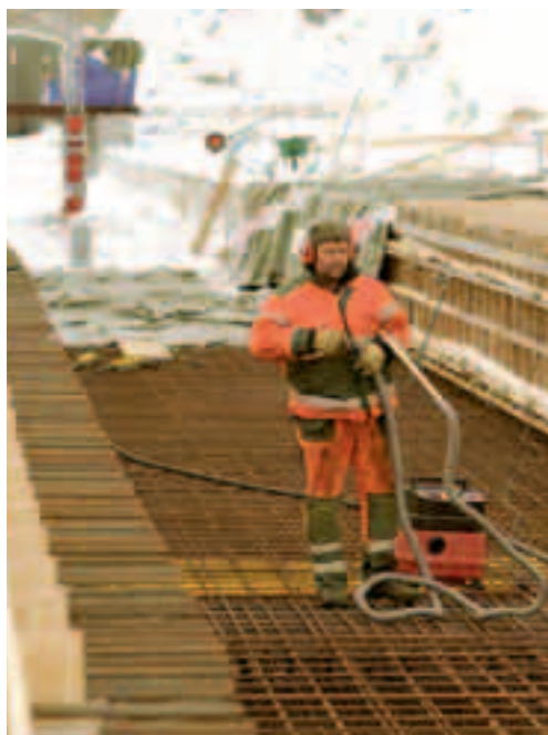
Bygge av den cirka 300 meter långa bron vid Husum resecentra.
