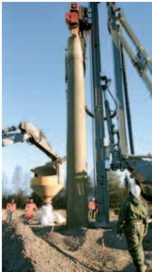
Markförstärkning i Strannyland. Sandpelare är ett försök med en ny metod för pålning av järnvägsbank.
